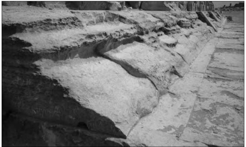
Abb. 8a: Extrem verwitterte Verkleidungsblöcke an der Westseite der Großen Pyramide.
