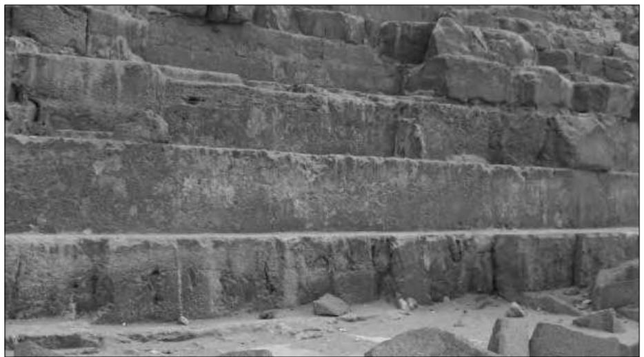
Abb. 18 (oben): „Chephren-Pyramide“, Nordseite: Achten Sie einmal auf die zweite Gesteinslage. Sehen Sie da irgendeine Fuge? Das ist tatsächlich ein Block! Den Transport und die Einpassung in die Ebene stelle ich mir recht schwierig vor. Nicht so die alten Ägypter.
